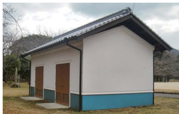
白杵公園防災倉庫
