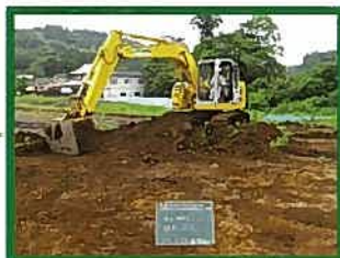
2.機械掘削状況
