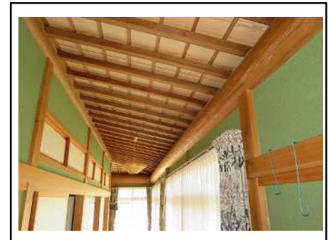
和室縁側の梁
